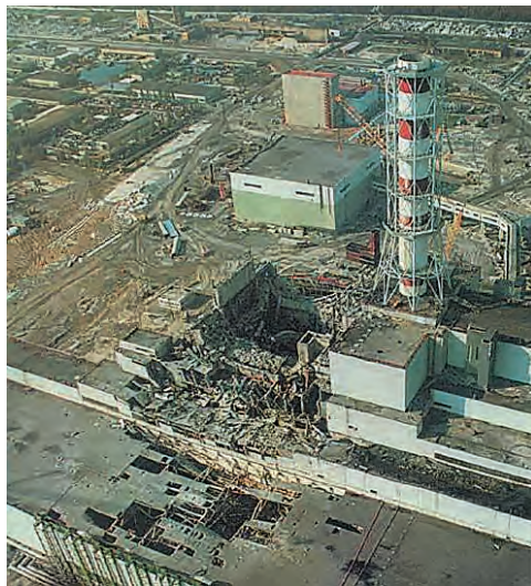
Зруйнований реактор на Чорнобильській АЕС
